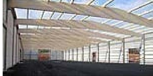
Cette poutre sert de support de toiture, nous allons la considérer comme étant sur deux appuis simples (schéma ci-dessous) ; elle est soumise à une charge linéique  $p$  que l'on considérera comme étant uniformément répartie.
