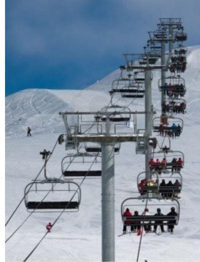
Nous nous intéressons aux effets des sièges, et de leurs passagers, sur la tension du câble porteur. Les deux modélisations proposées permettent de réaliser divers calculs pour un tronçon de câble. On note  $F$  l'effort vertical transmis par les sièges (Figures ci-dessous).
