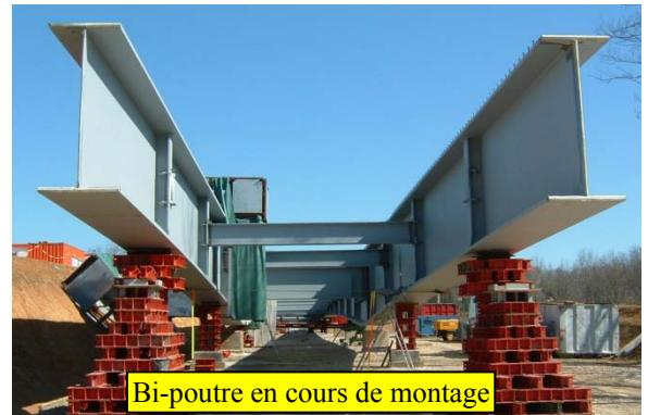
Nous considérons que les épaisseurs ( $t_f$  et  $t_w$ ) sont telles qu'aucun voilement local n'est à craindre sous l'effet d'un moment de flexion. Les sections restent planes (linéarité des déformations longitudinales).
