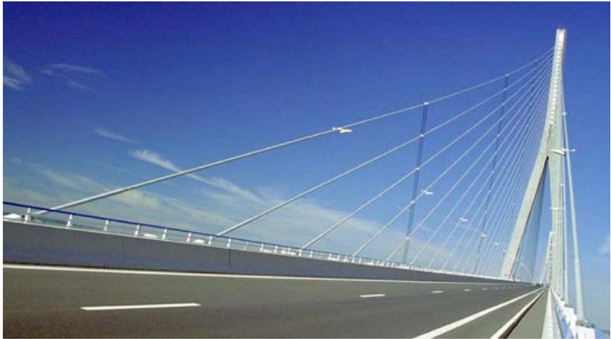
Chaque hauban est constitué d'un ensemble de torons enfermés dans une gaine de polyéthylène haute densité (PEHD). Nous allons nous intéresser au comportement d'un hauban formé de 55 torons T15 de diamètre nominal 15,3 mm (0,6") ; chaque toron étant lui-même constitué de 7 fils de diamètre 5 mm en acier galvanisé.
