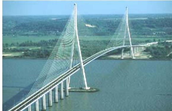
Ce pont fait l'objet, depuis le début de sa construction, d'un suivi géométrique des appuis des deux pylones, des culées, et des 26 piles des viaducs d'accès. La nature géologique du site et les très fortes charges transmises aux fondations en grande profondeur ont conduit la Maîtrise d'œuvre à contrôler l'évolution des tassements différentiels.
