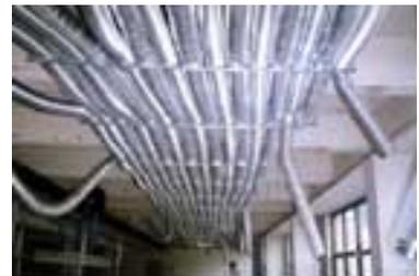
On peut alors considérer que le fonctionnement du réseau aéraulique ne générera pas de nuisance acoustique dans les locaux desservis ( $V < 6$  m/s dans les réseaux de distribution).
