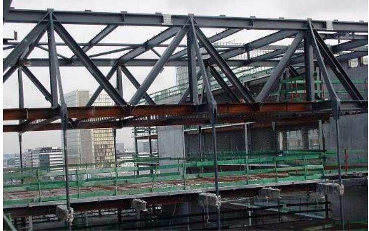
Nous allons analyser le comportement de ce type de poutre en considérant une modélisation élémentaire de *treillis*.
