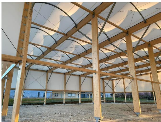
Figure 11 : Membrane textile architecturale de la toiture du gymnase.
