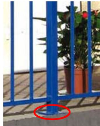
Sous l'effet de la charge horizontale appliquée à la lisse haute (cf. question précédente), on considère le modèle ci-contre de transmission des efforts à la dalle support (composante horizontale non représentée), par l'intermédiaire de la liaison représentée ci-dessus.
